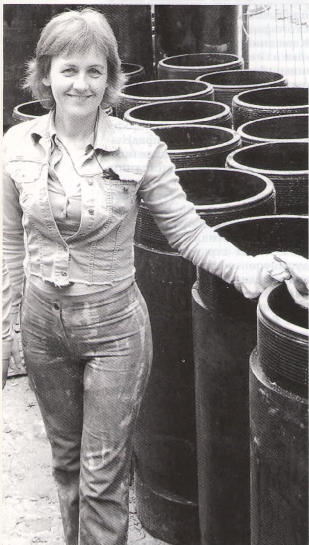
На объекте. Замена сливного коллектора. (Москва. Брюсов переулок.)
